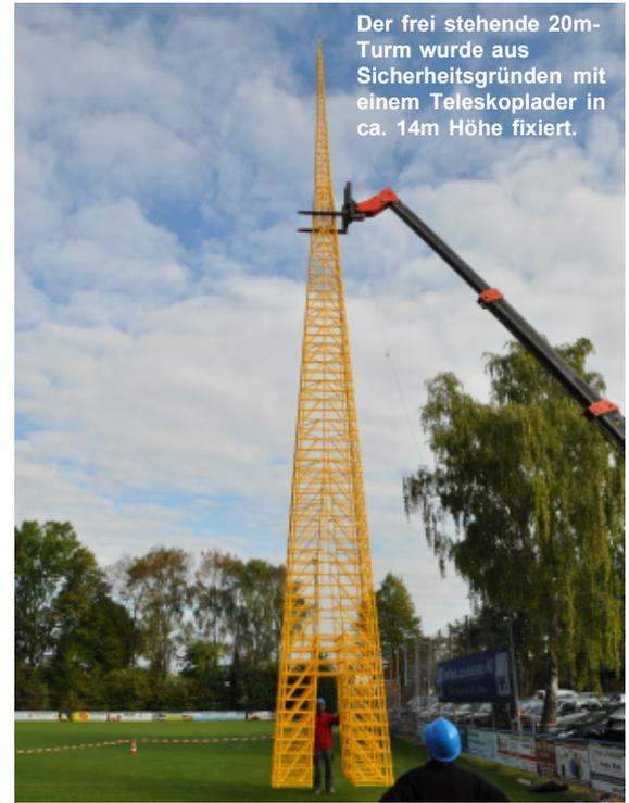
Der frei stehende 20m-Turm wurde aus Sicherheitsgründen mit einem Teleskoplader in ca. 14m Höhe fixiert.
